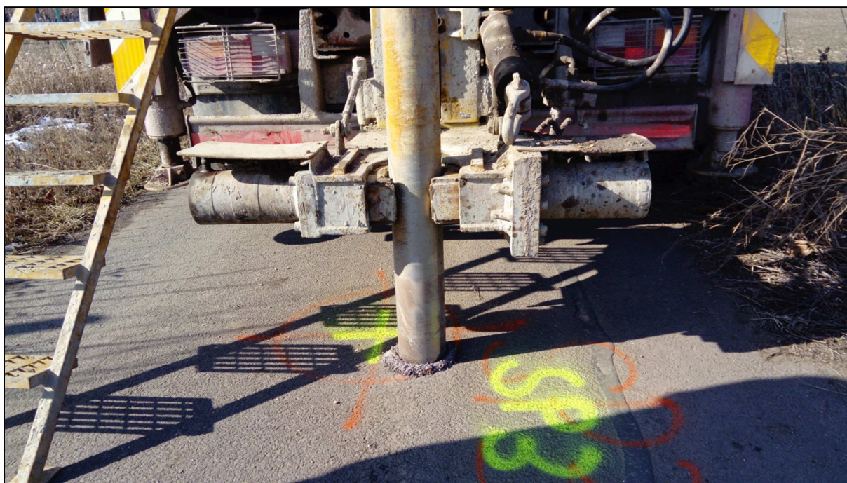
Foto 12: Pro dokreslení představy o vrtných pracích je uveden detail vrtné soupravy při návrvu pro statickou penetraci SP3, hloubky návrvů se pohybovaly okolo 0,5 m.
