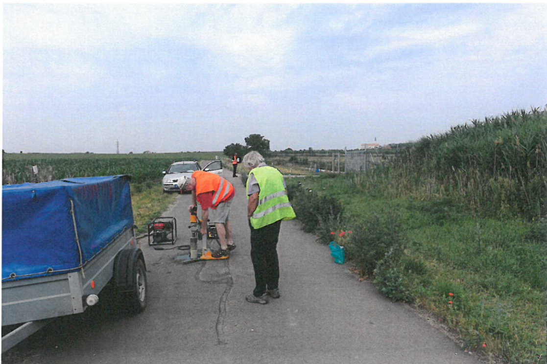
Obrázek P2 – Jádrový vývrt J.V. 3 odběr jádrového vývrtu z místa, kde byla při provádění použita sanace podloží lomovým kamenem
