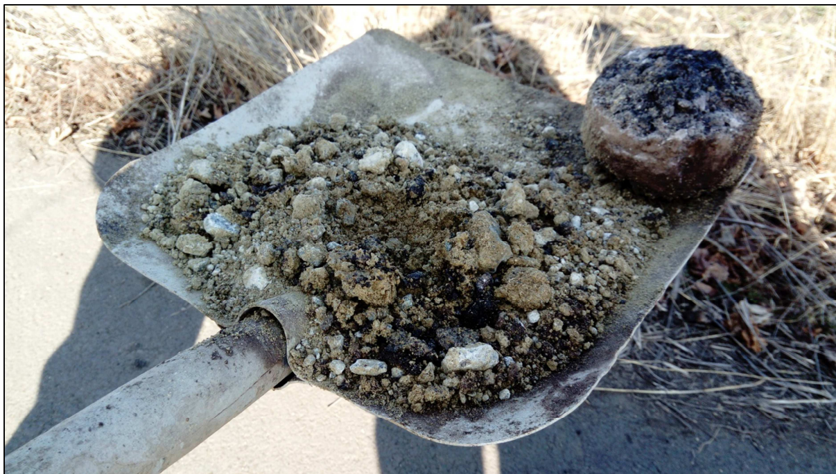
Foto 13: Detail návrtu na počátku „1. větve“ komunikace.
