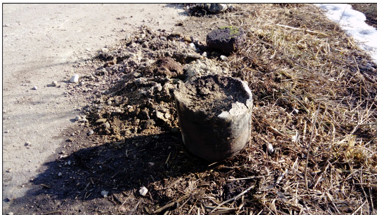
Foto 8: Fotografie z téhož místa návrtu, z jiného pohledu – patrné je jádro z ornice (stlačeno vrtáním), následované makadamem. Úplně vzadu je zátka asfaltobetonového krytu.
