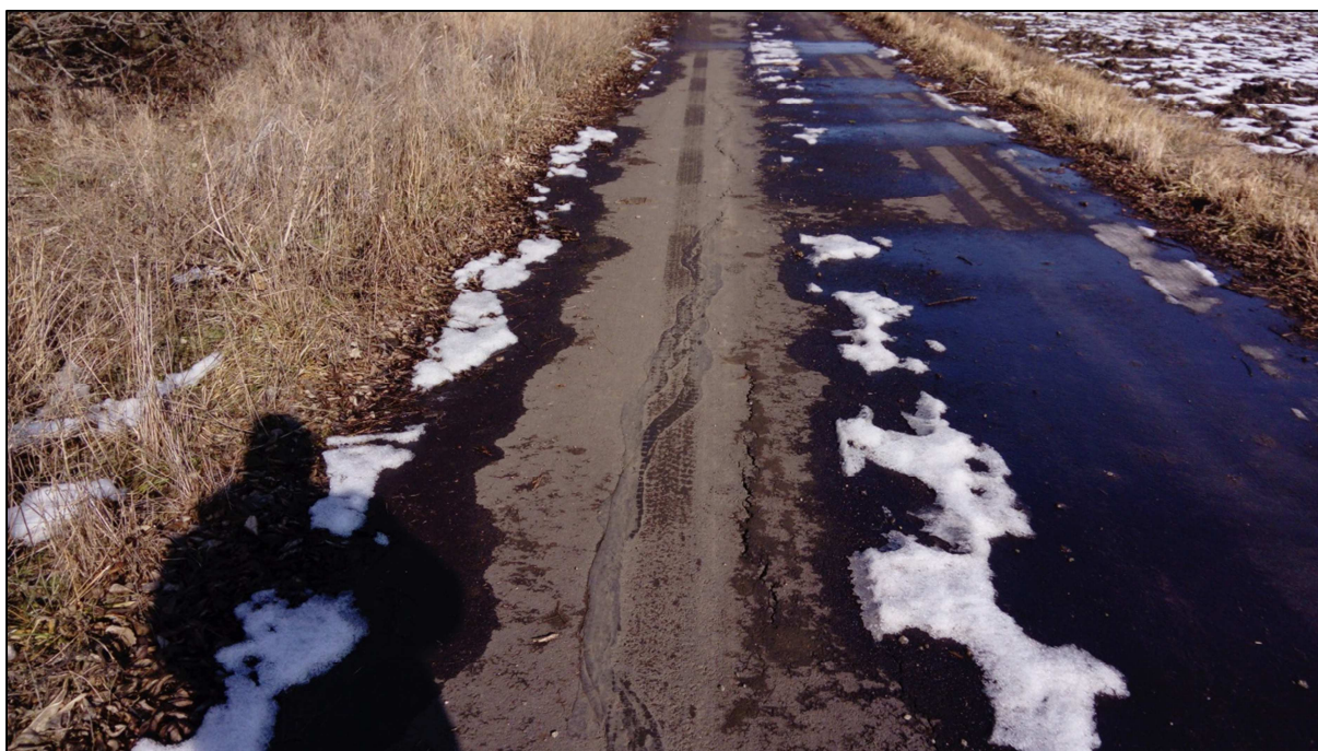
Foto 3: Motivační obrázek, který nepřímo poukazuje na možný dosah pneumatik těžké zemědělské mechanizace k okraji komunikace. Podloží si i přes nízkou frekvenci pojezdů žádá jednoznačné zajištění únosnosti vůči takovému zatížení.
