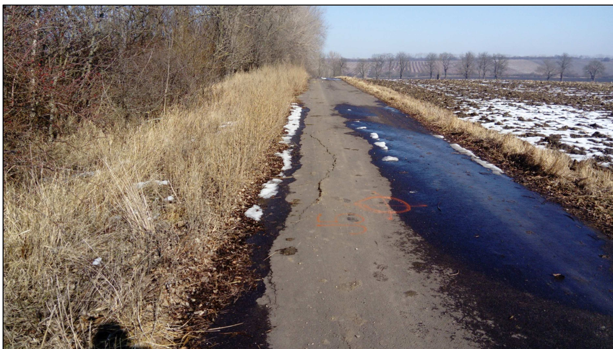
Foto 5: Porucha ve 3. části „1. větve“, blíže k „2. části“. Trhlina je výsledkem odlomení části vozovky – v místě je jednoznačná skoková změna sklonu povrchu odlomení a zbytku vozovky.
